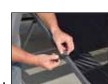
**Paso 5:** Bloquear el control deslizante Quik pestillo en su lugar presionando abajo en la parte superior de la pierna mientras tira hacia arriba de la deslizadora. Tenga en cuenta que hay dos puntos de cierre en cada pierna. Comience con la primera de las cuatro esquinas (Fig. E.). A continuación, haga clic en la siguiente posición para tirar de la dosel superior apretado. (Fig. F.).
